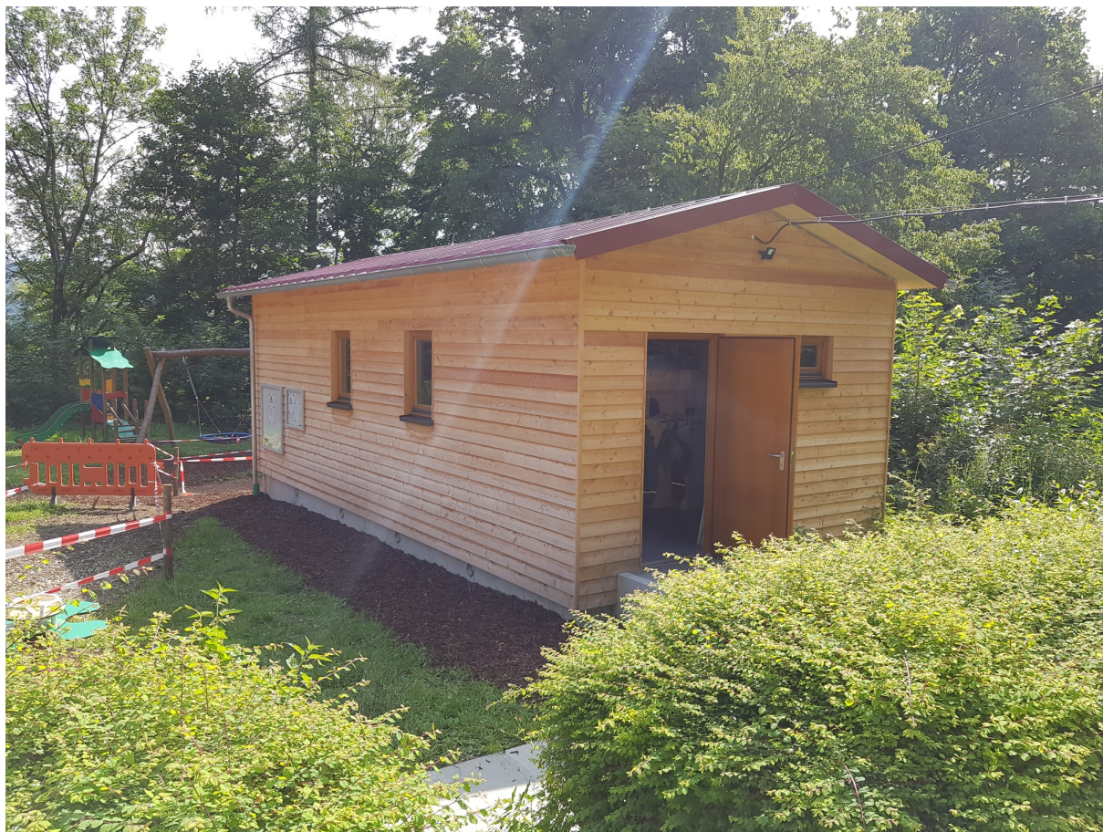
Bereits im Betrieb: die neu gebaute Schutzhütte für den Naturkindergarten
