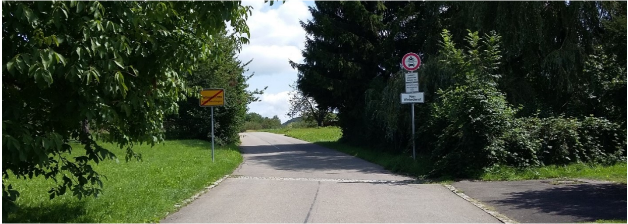
Ortsansicht ortsauswärts in Verlängerung der Kühsteiggasse.
