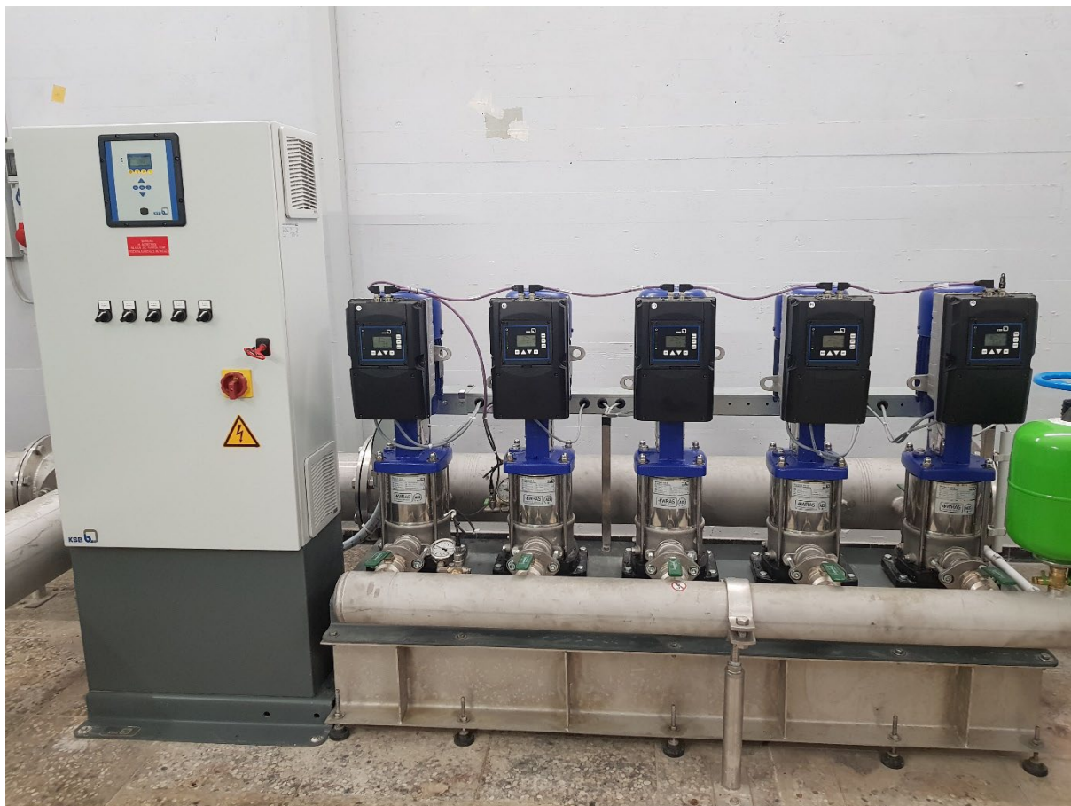
Erneuerte Pumpen im Hochbehälter Kühsteige
