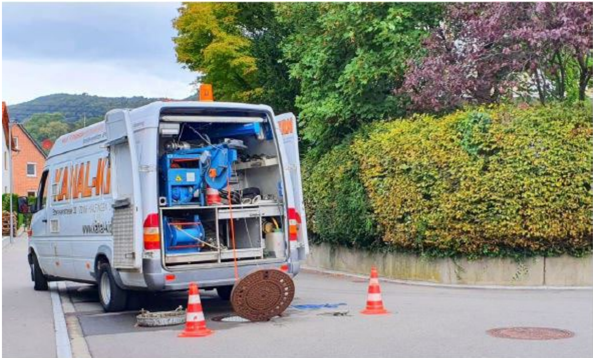
Ein Fahrzeug der beauftragen Firma Kanal-Kirn bei der Kanaluntersuchung. © Gauss Ingenieurtechnik
