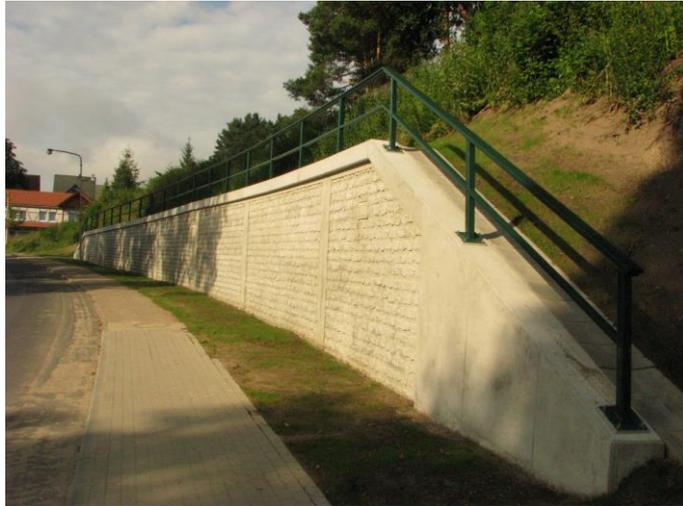
**Abbildung 5.4:** Beispiel für eine Absturzsicherung an einer Stützwand
