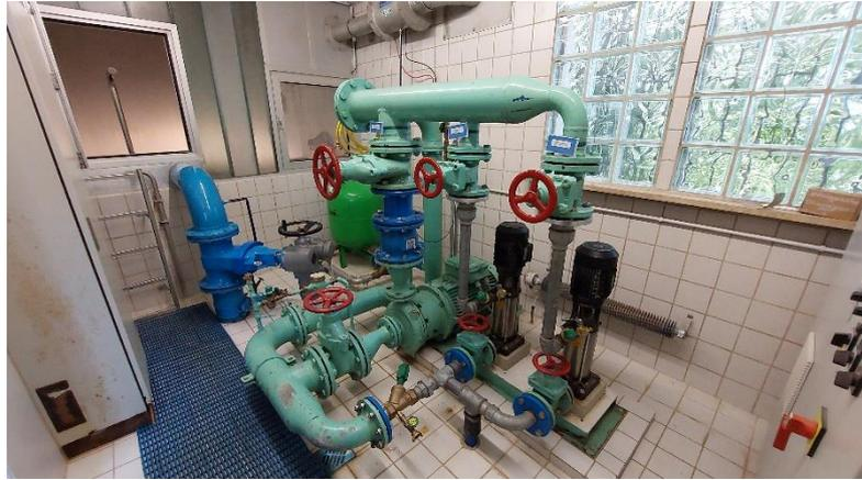
**Abbildung 1.3:** Innenansicht mit Blick auf den Eingang zur Wasserkammer und der Druckerhöhungsanlage Ackerloch/Königshöhe
