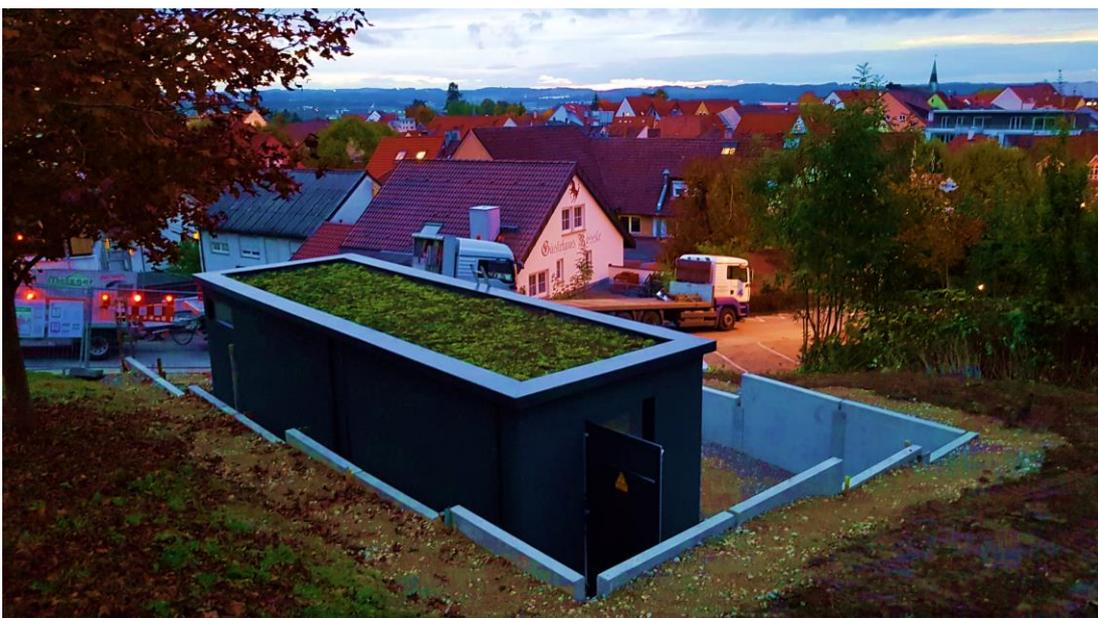
**Abbildung 2.5:** Beispiel für eine Trafostation mit begrüntem Flachdach und WDVS in dunkler Farbgebung
