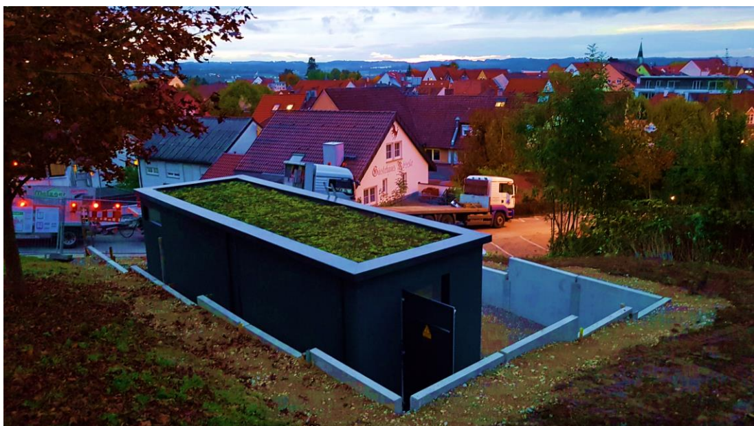
Abbildung 2.5: Beispiel für eine Traffostation mit begrüntem Flachdach und WDVS in dunkler Farbgebung
