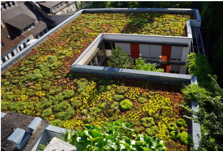
Abbildung 2.4: Beispiel für ein begrüntes Flachdach mit Attika (links) und schematischer Aufbau mit Wärmedämmung (rechts)
