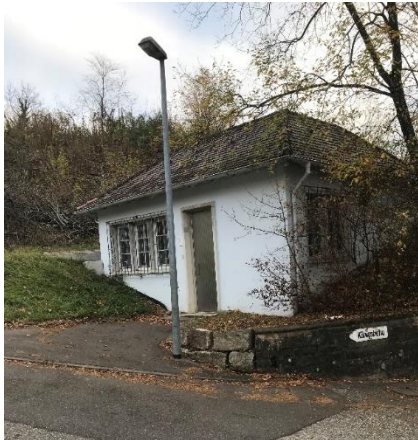
Abbildung 1.4: Außenansicht Pumpwerk Königshöhe
