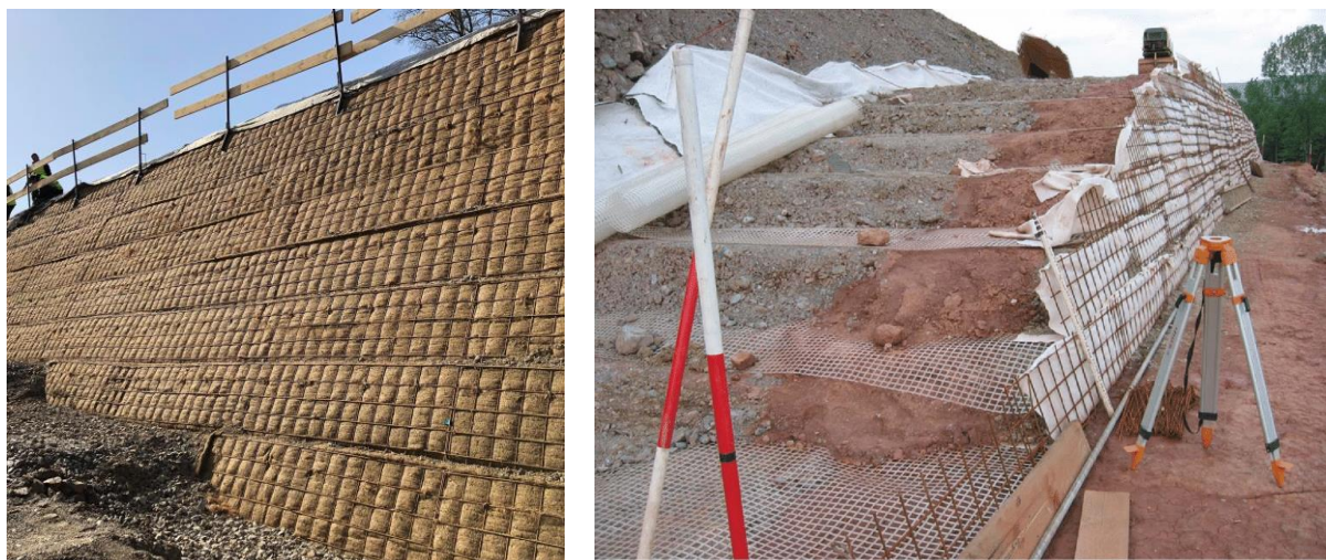
Abbildung 2.7: Ausführungsbeispiele für Bewehrte-Erde-Konstruktionen als Böschungssicherung: Fertige Konstruktion ohne Bewuchs (links), Herstellung und Verfüllung mit Bodenmaterial (rechts) und schematischer Aufbau (unten)
