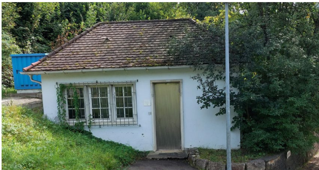
Das aktuelle Betriebsgebäude des Hochbehälters Königshöhe
