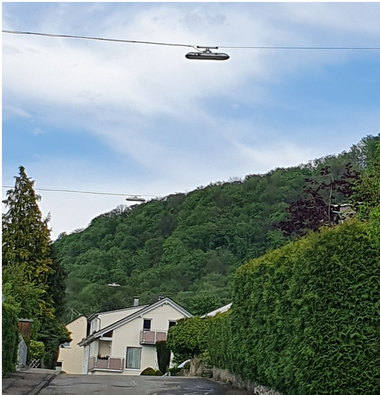
Noch schwebt die Straßenbeleuchtung über der Fahrbahn: Freileitungen in der Buchhalde
