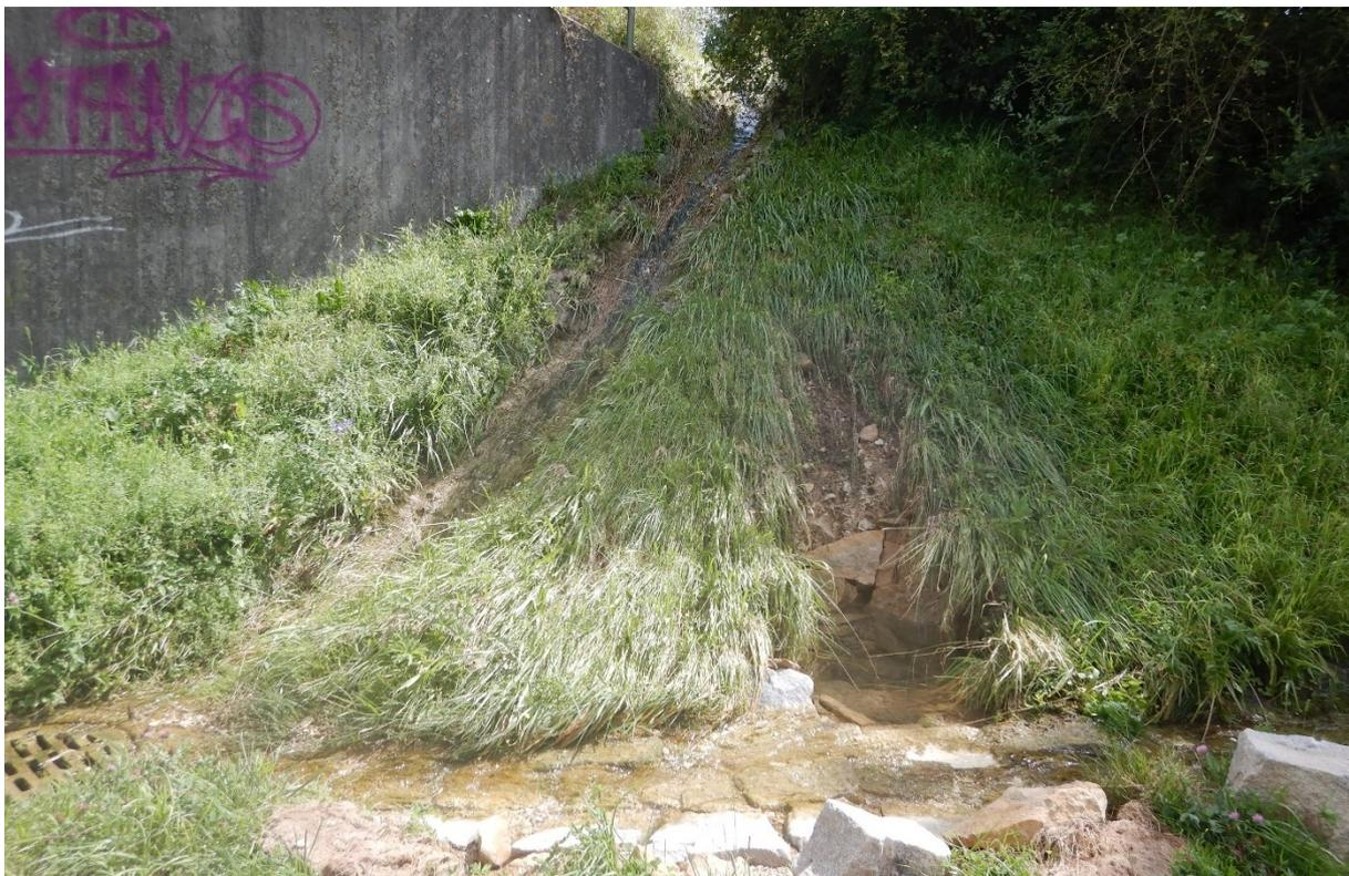
**Abbildung 21: Böschungserosion nach einem Regenereignis im Juni 2019 am rechten Einlauf südlich der Unterführung an der B28**
