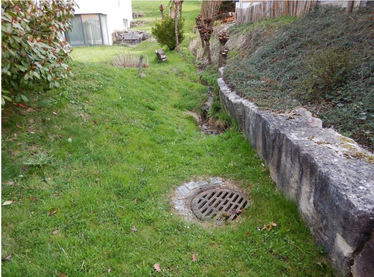
**Abbildung 9: seitlicher Grabeneinlauf an der Justrasse**
