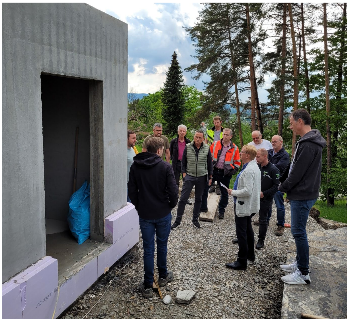
Die Mitglieder des Technischen Ausschusses vor dem Rohbau des neuen Betriebsgebäudes.
