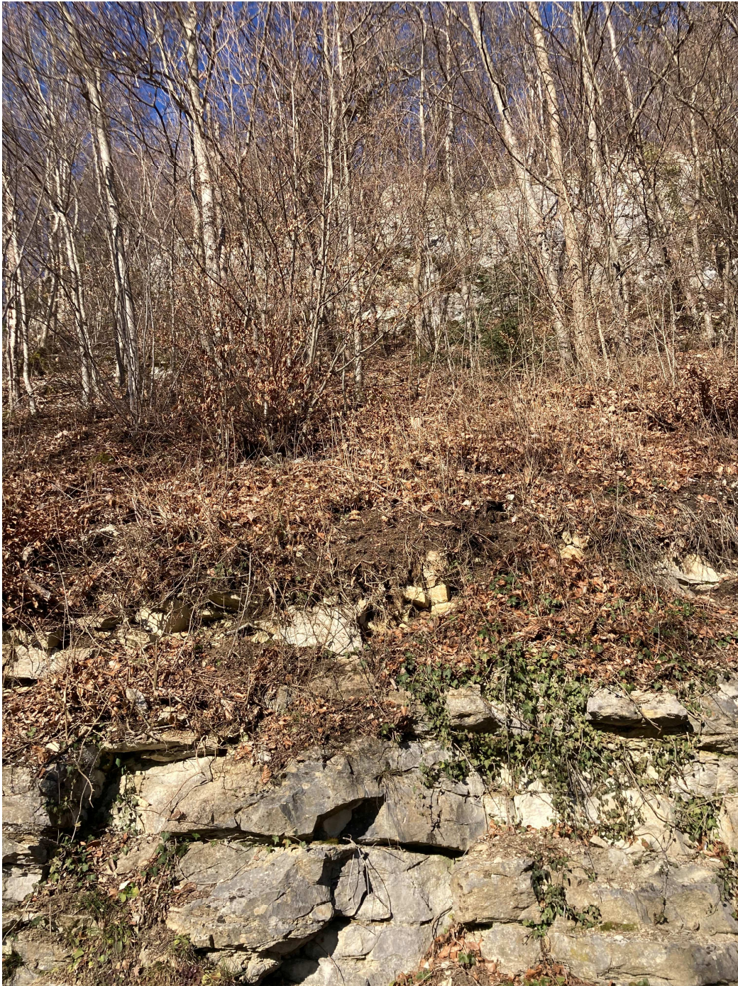
15.02.2023 – nachgelagerte Felsformationen oberhalb im Wald mit absturzgefährdeten Felspartien
