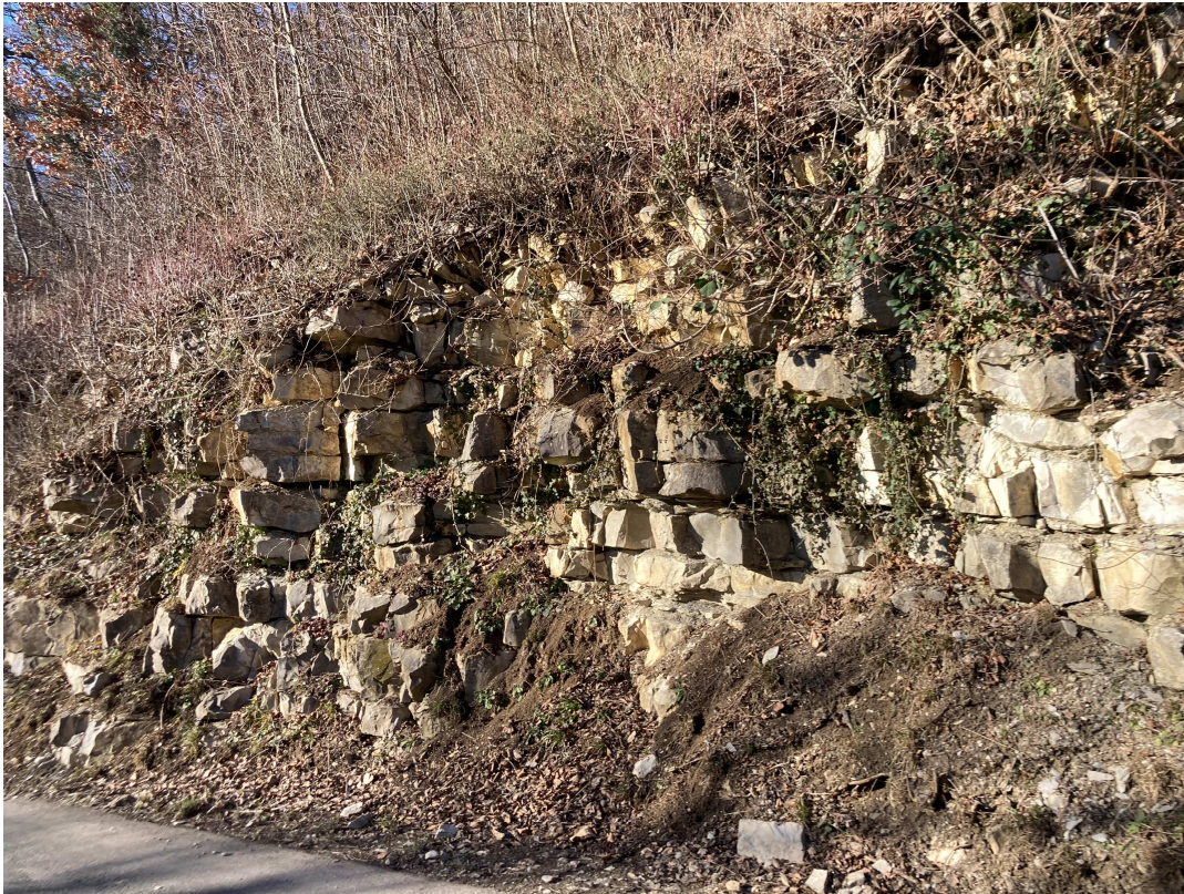
15.02.2023 – freiliegende, wohlgeschichtete Kalke mit dünnen Mergelsteinlagen
