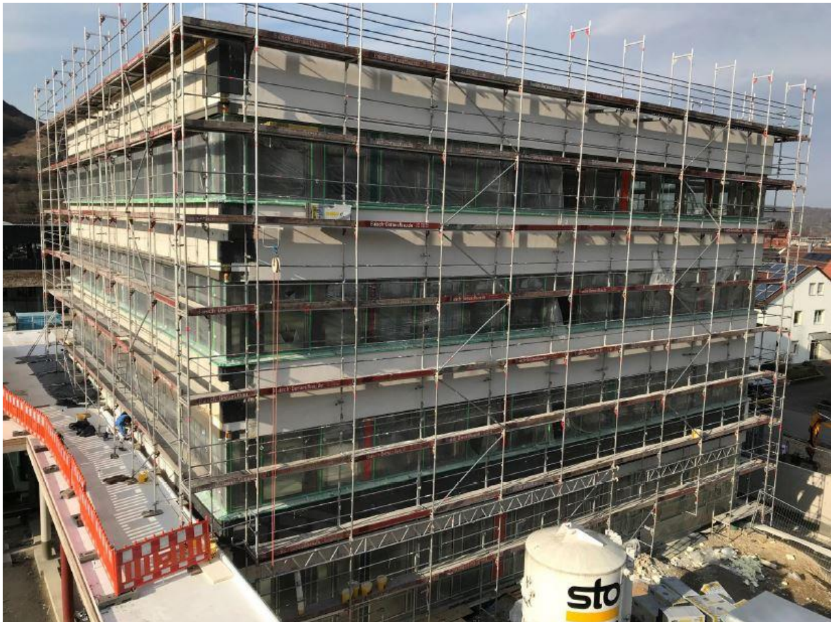
Die aktuelle Außenansicht des Neubaus Gebäude G2.
