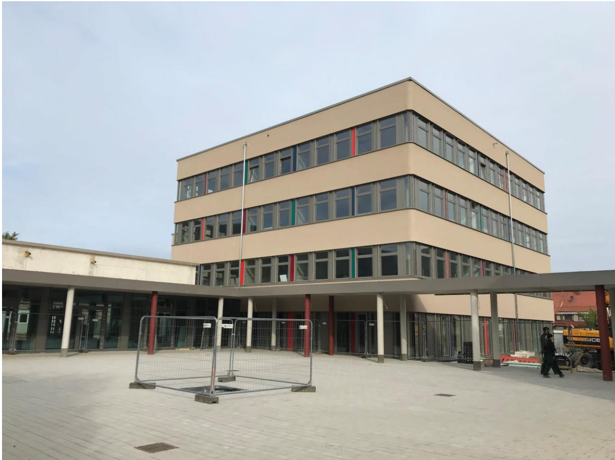
Das neue Gebäude G2 in seiner vollen Pracht nach Fertigstellung der Fassadenarbeiten.
