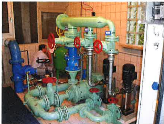
Abbildung 3-3: Druckerhöhungsanlage Königshöhe und Acker / Loch
