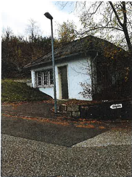
Abbildung 3-2: Betriebsgebäude PW Königshöhe
