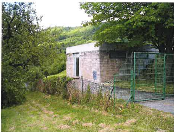
Abbildung 3-21: Betriebsgebäude HB Kühsteige
