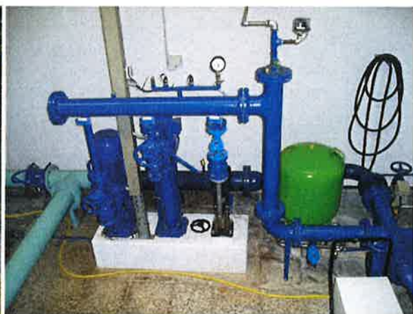
Abbildung 3-22: Druckerhöhungsanlage Oberer Wolfgarten
