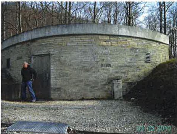
Abbildung 3-13: Bediengebäude HB Buchhalde
