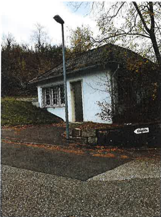
Abbildung 3-2: Betriebsgebäude PW Königshöhe
