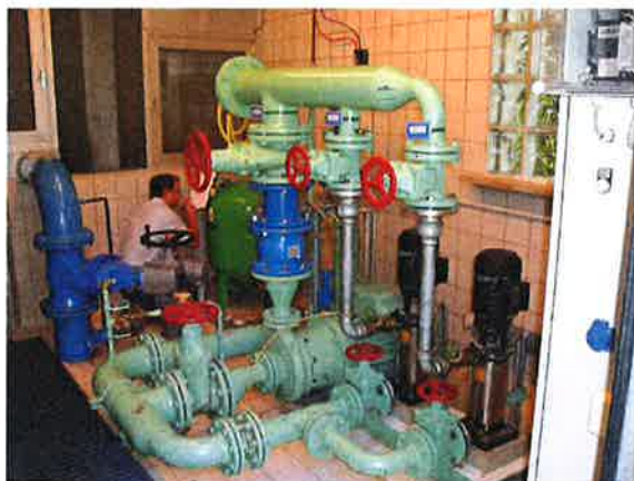
Abbildung 3-3: Druckerhöhungsanlage Königshöhe und Acker / Loch
