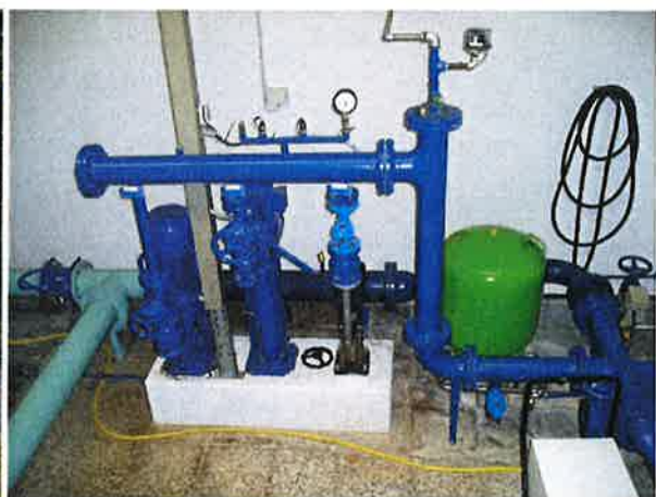
Abbildung 3-22: Druckerhöhungsanlage Oberer Wolfgarten
