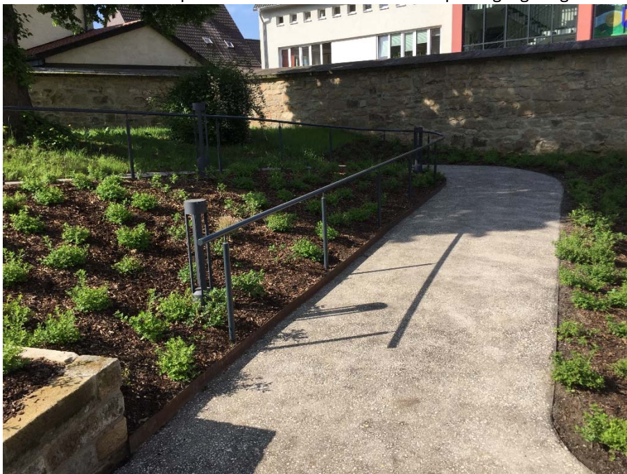
Bild 1 Beispiel Gestaltung asphaltierte Rampe
