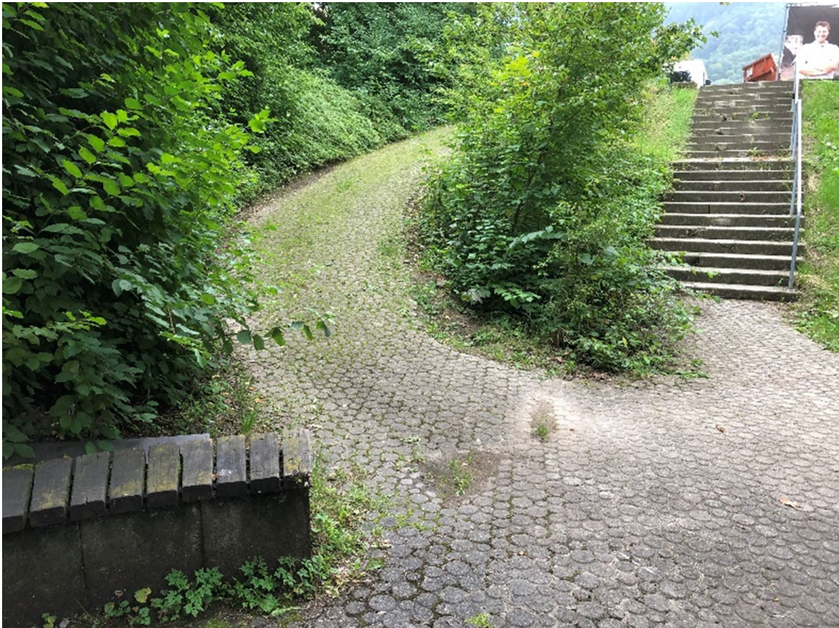
Der Tiefhof vor dem Gebäude G3 an der Schillerschule: Die im November beschlossene deutlich kleinere Variante der Sanierung spart nochmals Geld im Haushalt.
