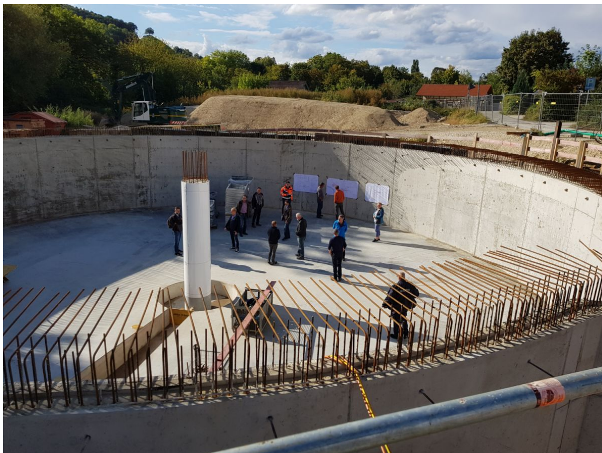
Informationsbeschaffung im Herzen des Bauwerks: Das Gremium im Becken des RÜB Gweidach.
